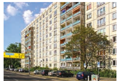
Abb. 43: Betonplattenbauten des komplexen Wohnungsbaus
