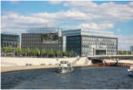
Abb. 31: Büro- und Geschäftshaus
