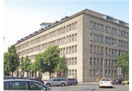
Ansicht des Gebäudes Fehrbelliner Platz 1
